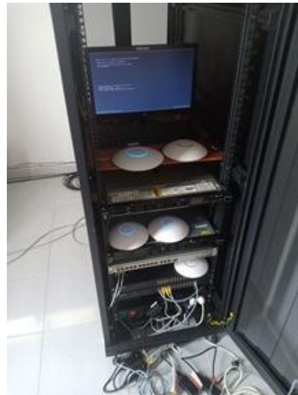
Gambar 7. Penambahan router, switch manageable, dan AP Unifi untuk keperluan konfigurasi sistem jaringan
